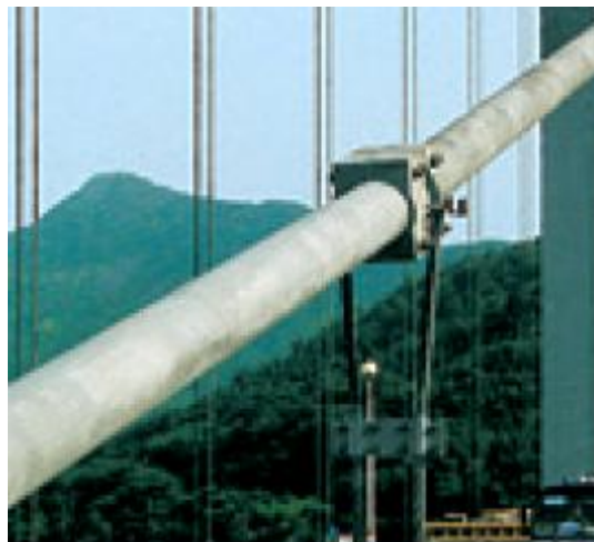
Slika 2. Neprekidno merenje deformacije elementa mosta [7]
